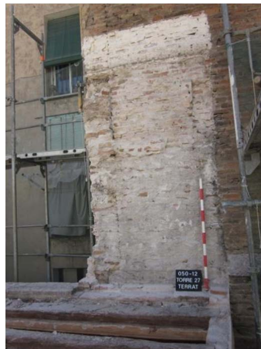
Sotstinent Navarro, 14. Enderroc del terrat i detall de com s'anava alliberant el parament frontal de la torre 27
