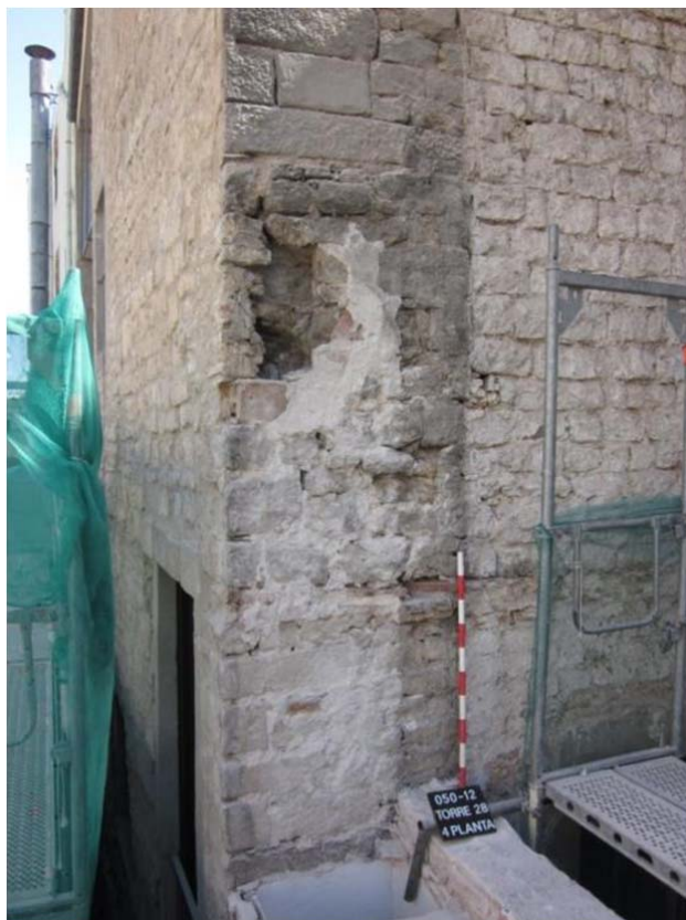
Sotstinent Navarro, 16. Enderroc del 4t pis. Vista del parament lateral de la torre 28 on s'aprecia la filada de maons (UE 19) que marca el capdamunt de la torre romana i l'inici de la remunta medieval (UE 20).
