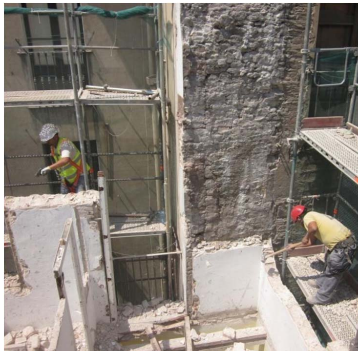
Sotstinent Navarro, 14. Enderroc manual del 4t i del 3r pis
