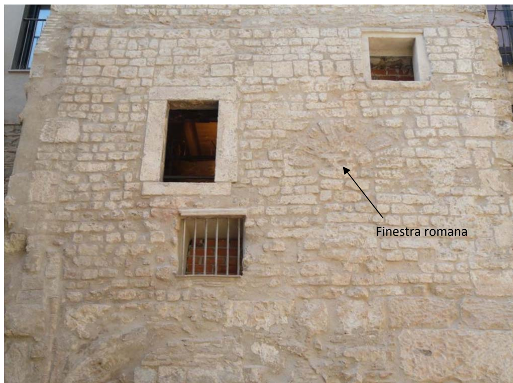
Sotstinent Navarro, 16. Vista general de la finestra en la paret d' opus certum (UE 17) de la torre 28
