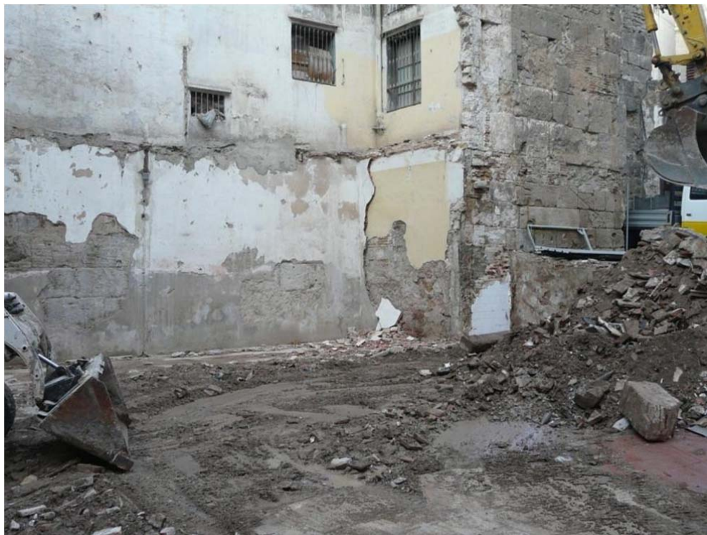
Sotstinent Navarro ,14. A dalt. Vista de l'enderroc des del terrat de la finca veïna de Baixada del Caçador, 6. A baix. Enderroc de la planta baixa.
