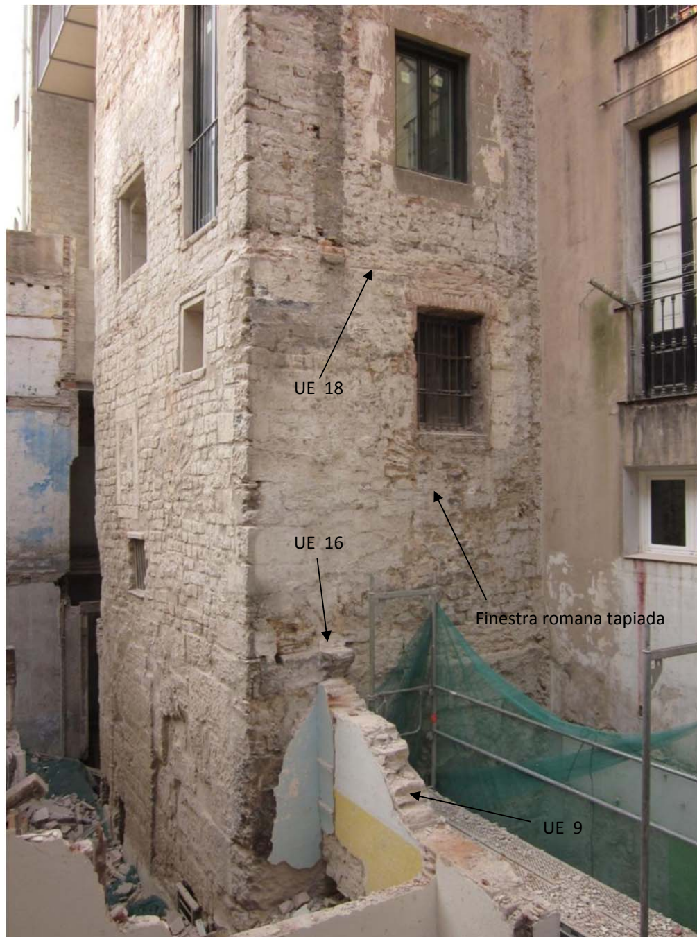
Sotstinent Navarro, 16. Vista de la torre 28 a l'alçada del 1r i del 2n pis de la finca. Es pot veure el tros de cornisa motllurada que ha perviscut (UE 16), alineat amb el mur posterior (UE 9) que s'adossa a la torre. També s'aprecia la finestra romana tapiada, i la cornisa repicada de maons (UE 18) que remarcava la separació entre els pisos de la torre.
