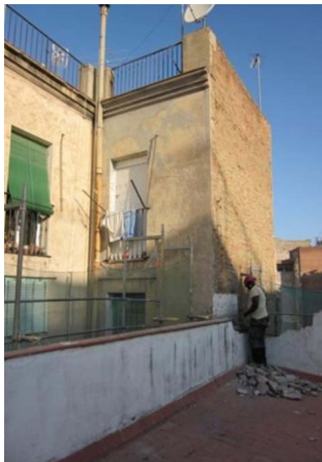
Sotstinent Navarro, 14. Vista del terrat de la finca i de les parets posterior (oest) i lateral (nord) que s'adossen a la torre 27
