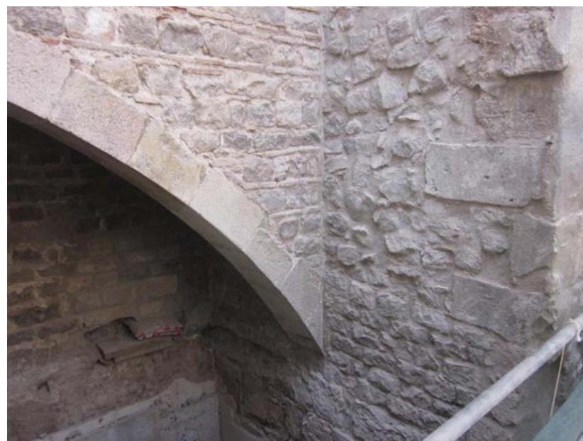
Sotstinent Navarro, 16. Vista i detall de l'arcada (UE 26) entre les torres 28 i 29.
