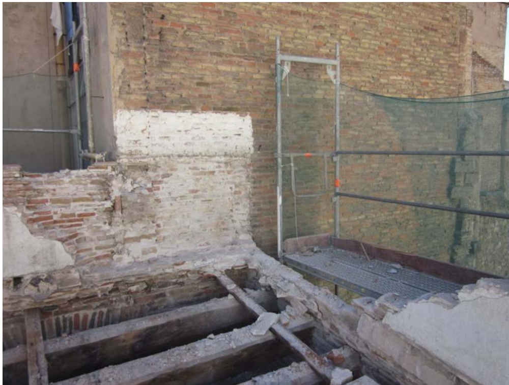
Sotstinent Navarro, 14. Enderroc del terrat i detall de com s'anava alliberant el parament frontal de la torre 27
