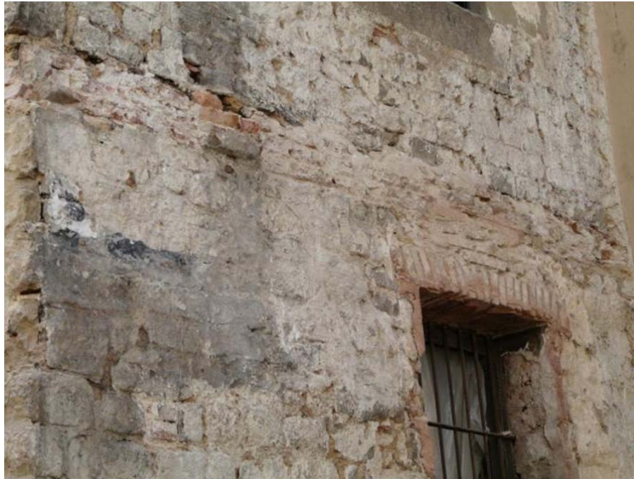
Sotstinent Navarro, 16. En l'enderroc de la part baixa del 3r pis s'ha pogut apreciar en detall la cornisa de maons (UE 18) de la cara nord de la torre 28.
