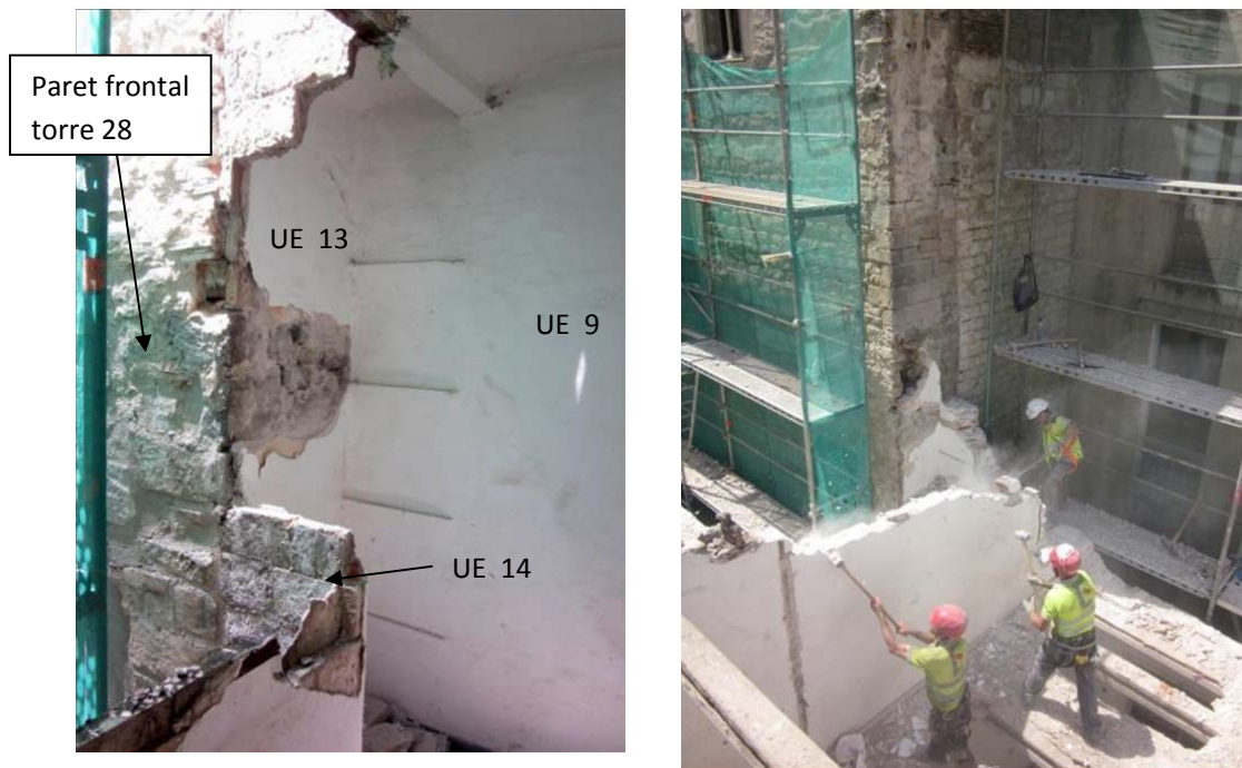
Sotstinent Navarro, 16. Diverses vistes de l'enderroc del 4t pis : A l'esquerra, detall del repicat de l'habitació que ocupava el reclau de l'edifici. A la dreta, enderroc manual de la paret mitgera entre les dues finques n.14 i n.16.
