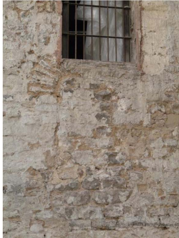
Sotstinent Navarro, 16. Detall de la finestra romana inferior del lateral nord de la torre 28.
